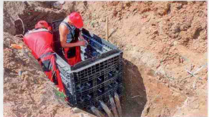
Kabelschächte aus Kunststoff bieten einige Vorteile: Sie sind relativ leicht, flexibel an die Einbaubedingungen vor Ort anpassbar, können schnell gesetzt werden und besitzen eine gute Statik. | Fotos: Langmätz
